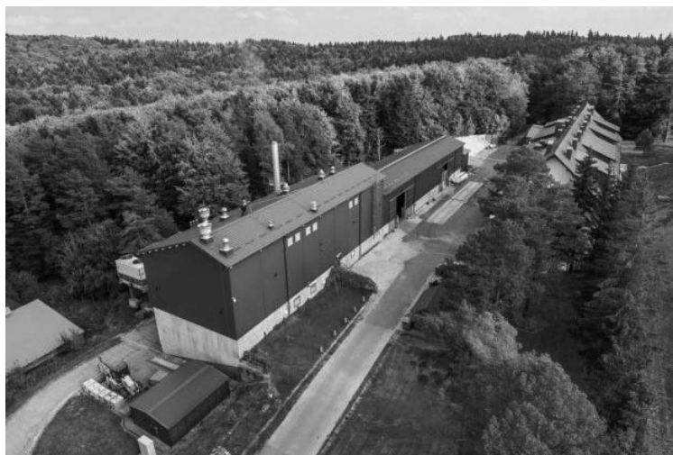
Fot. 9. Elektrociepłownia hotel Arłamów
